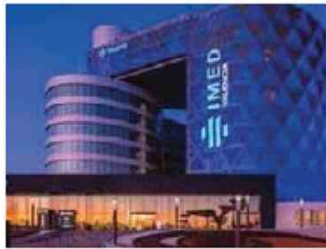
Axa IM a acquis l'hôpital Imed, situé à Valence.
